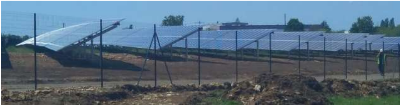
Exemple de fermeture de site par une clôture en mailles souples (source : Impulsion)
