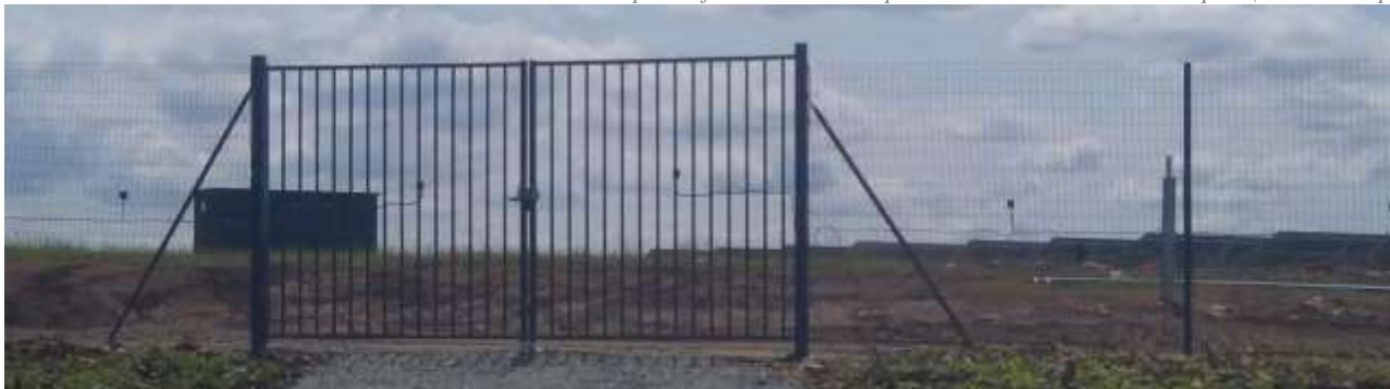
Exemple de fermeture de site par un portail à deux vantaux (source : Impulsion)
